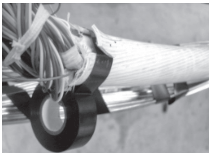
3) Vystříhnete kabelový plášť v délce 20 mm a šířce 10 mm. PVC pásku oviňte pod tímto výstřížkem.
