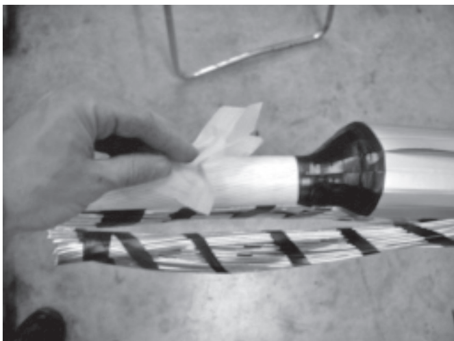
9) Očistěte přiloženým ubrouskem konce kabelu v délce 200 mm.
