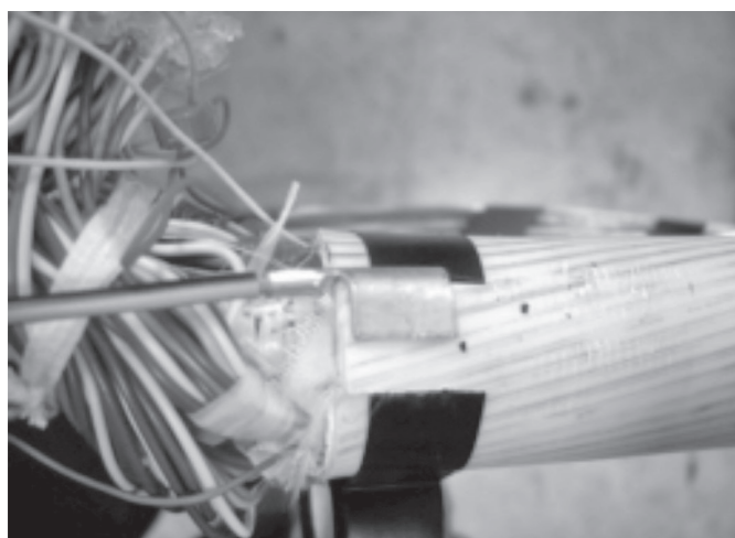
4) Připevněte krokosvorku propojovacího vodiče. Lze použít standardní kleště.
