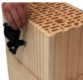
▲ Vnitřní strana budovy
